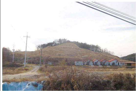
사진 4. 전원주택단지 조성 중
